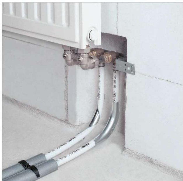
Fig. 5-7 Calorifer cu robinet cu cot de perete scurt 16-Rp½ RAUBASIC pe suport O 50 REHAU
