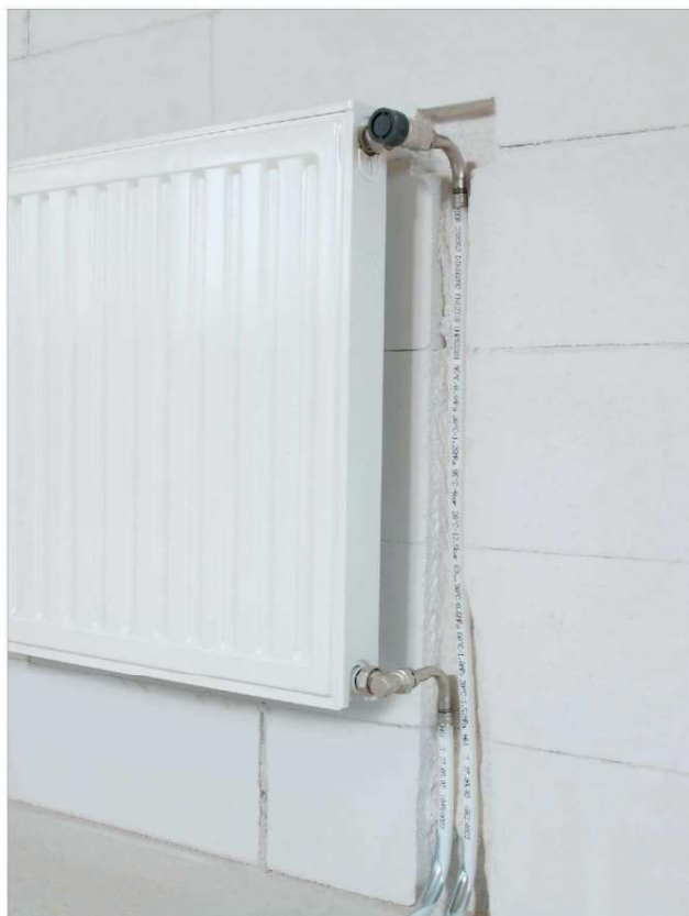
Fig. 5-1 Calorifer compact cu tijă de racordare în L RAUBASIC la calorifer
